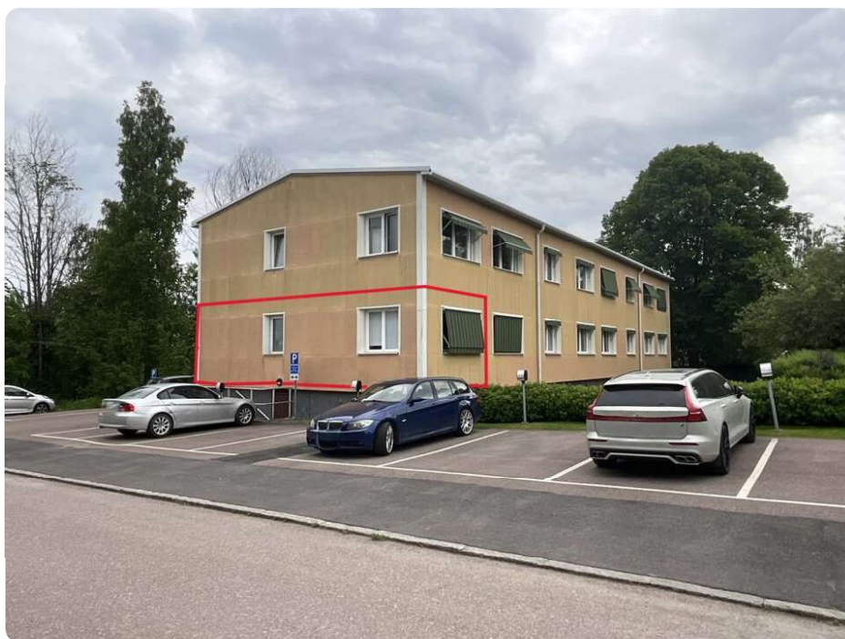
Flerfamiljshusets fasader mot nordväst och sydväst. Lägenhetens position markerad.
