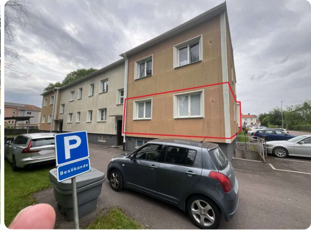
Flerfamiljshusets fasad mot nordost med portingång. Lägenhetens position markerad.
