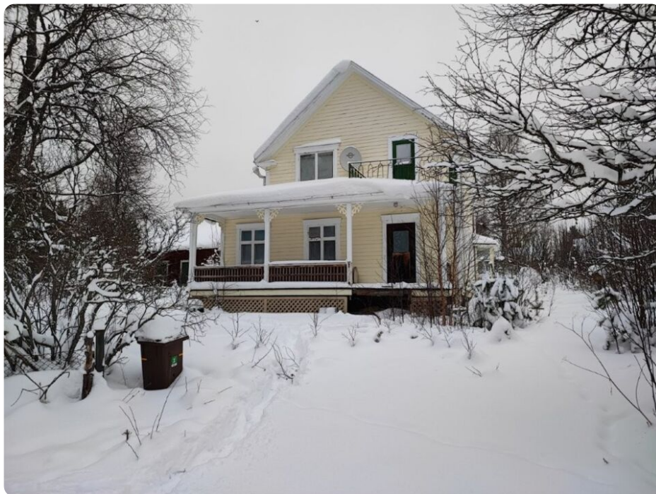
Foto huvudbyggnad med ljusgul fasad med vita detaljer samt veranda och balkong
