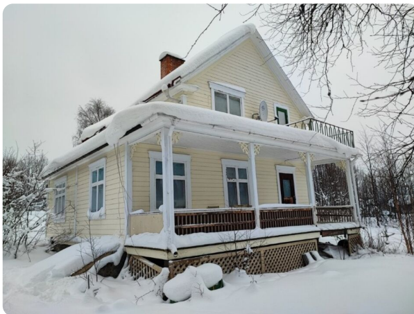
Verandan och balkongen på framsidan av huset
