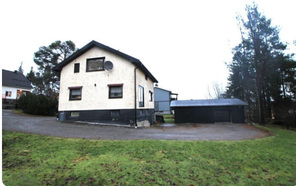
Foto huvudbyggnad, fasad med ljus puts, mörka detaljer. Garage med mörk träpanel.
