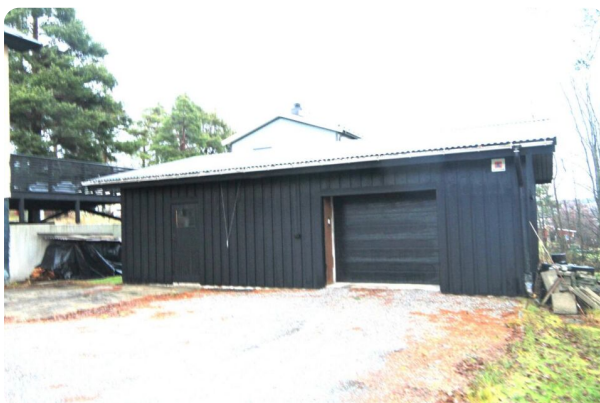
Foto garage med mörkgrå träpanel, garageport.
