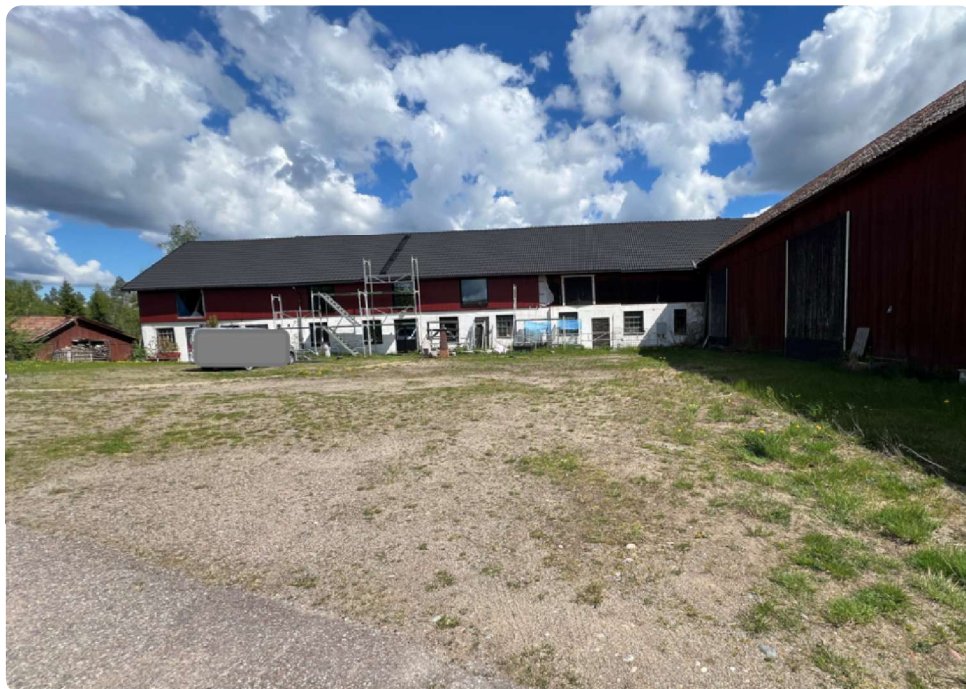
Ladugårdsbyggnad i vinkel under ombyggnad till bostad
