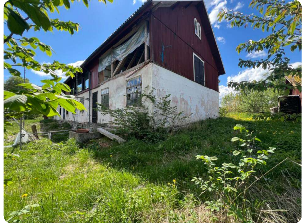
Ladugårdsbyggnad under ombyggnad till bostad, vy byggnadens gavel
