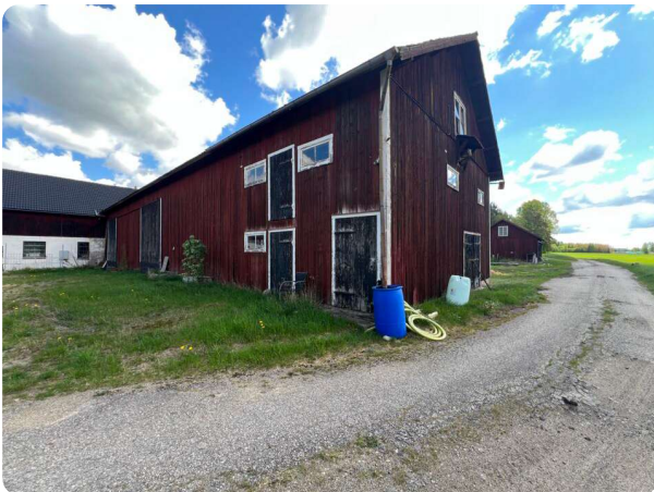
Del av ladugårdsbyggnad med rödmålad träfasad
