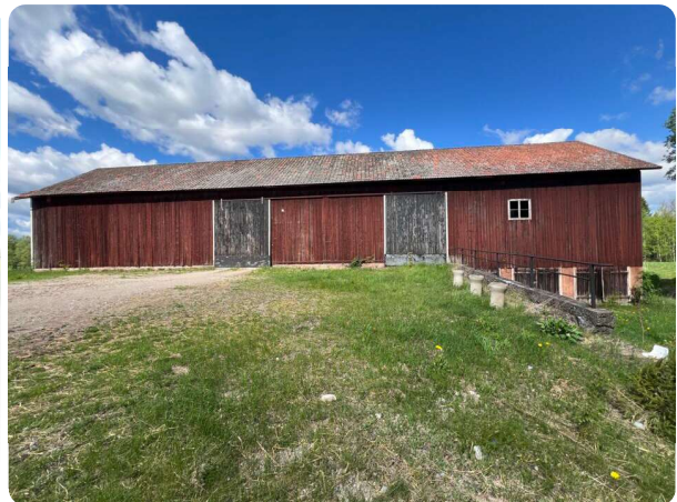
Del av ladugårdsbyggnad med rödmålad träfasad
