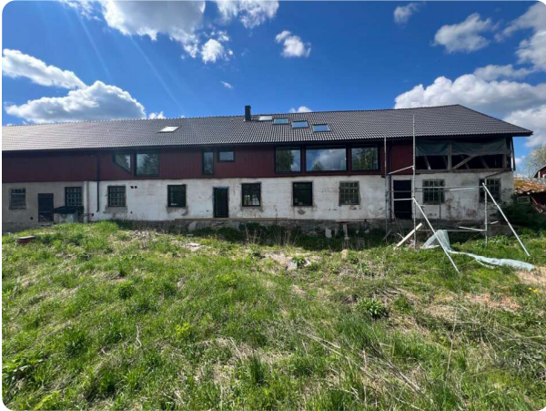
Ladugårdsbyggnad under ombyggnad till bostad, vy från baksidan
