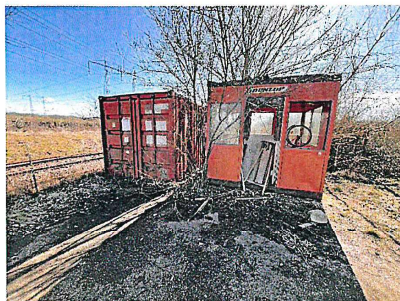
Foto, tomt (container & byggbod)
