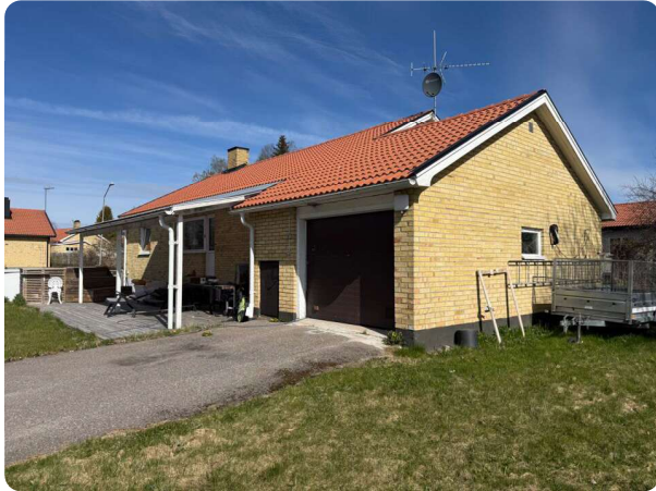
Huvudbyggnaden från söderläge med garage och veranda.
