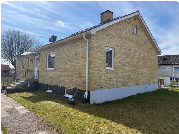
Byggnadens entrésida. Skärmtak över entré.
