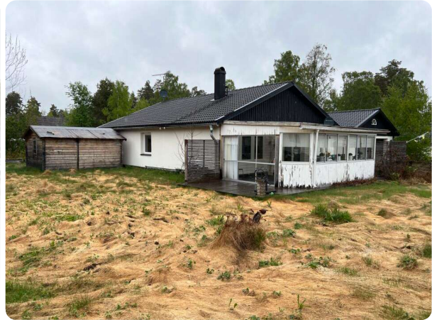
Bostadshus med inglasad altan samt högvuxen gräsmatta
