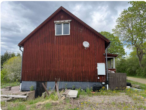
Huvudbyggnadens gavel och ingång till källare.
