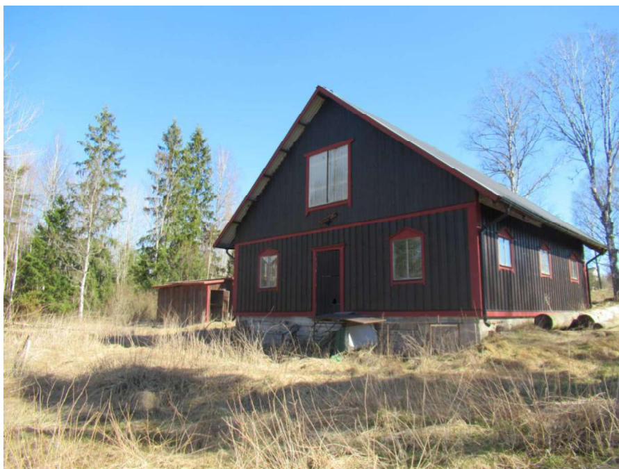
Foto taget utvändigt på stallbyggnad vid Skäggebyn. Brunmålad byggnad med plåttak och omgivande åker och betesmark.
