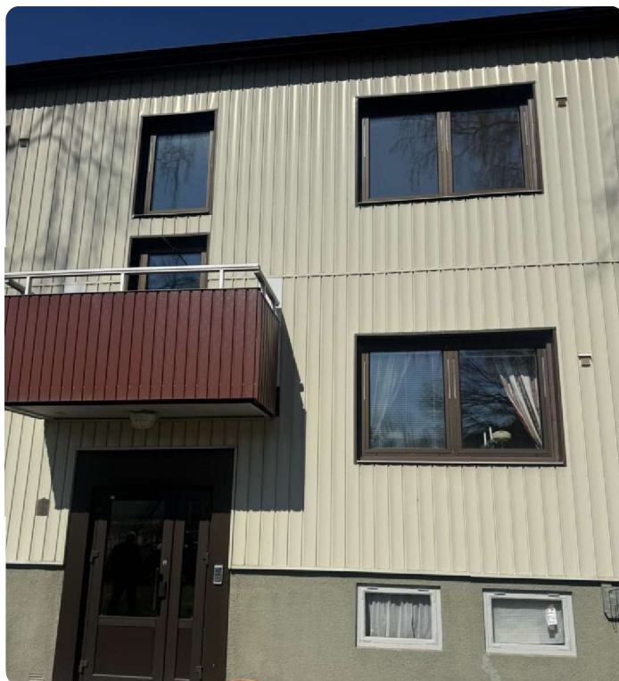
Värderingsobjektet utvändigt på våning 2. Plåtfasad.
