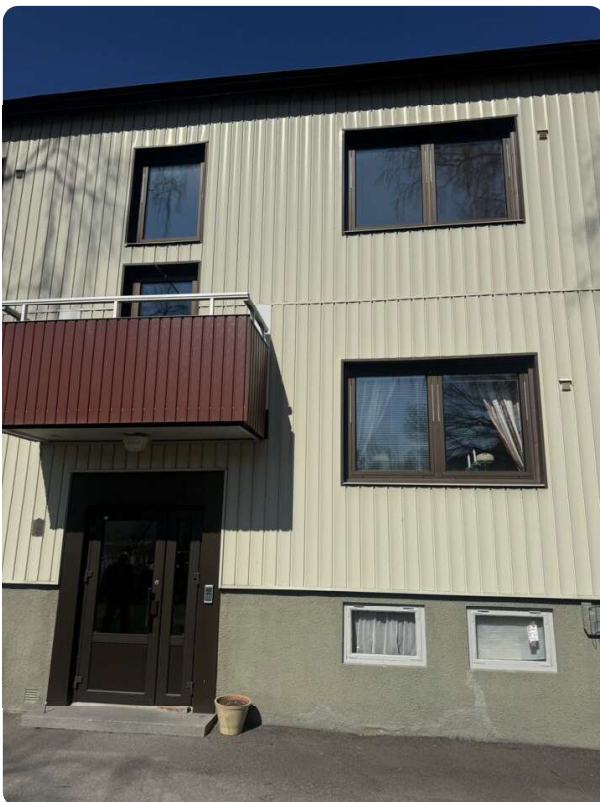
Värderingsobjektet utvändigt på våning 2. Plåttfasad.
