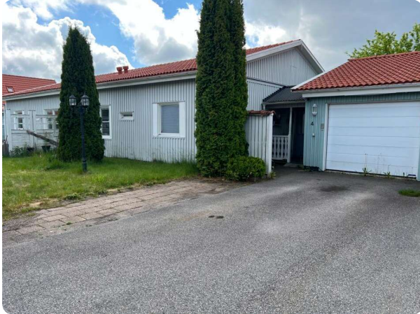
Del av parhus, garage samt infart och trädgård med gräsmatta
