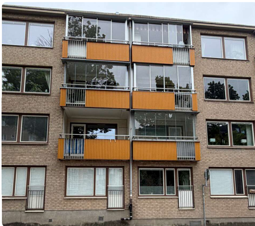
Foto taget på fastigheten utvändigt. Byggnad med grå tegelfasad med bruna fönsterkramsinfattningar
