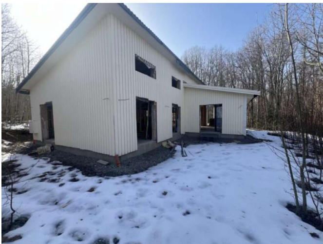
Foto, mark och byggnation. Grusad yta, naturmark och ej färdigställt bostadshus.
