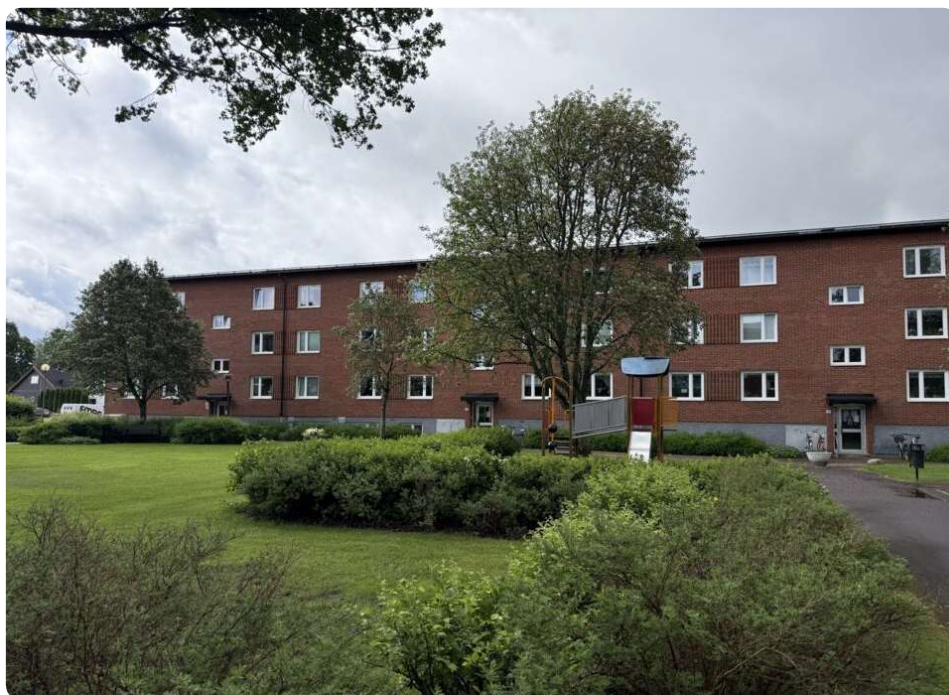
Byggnad med tegelfasad i 3 våningar med omgivande grönområden
