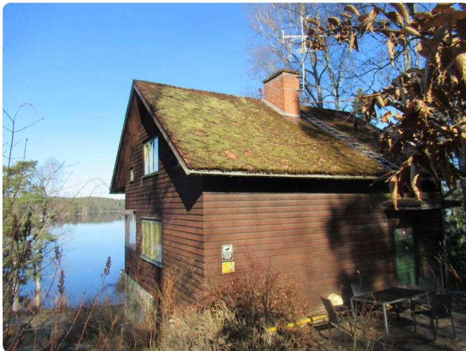
Byggnad med brunfärgad träpanel samt tomtmark i suterräng mot sjön Racken
