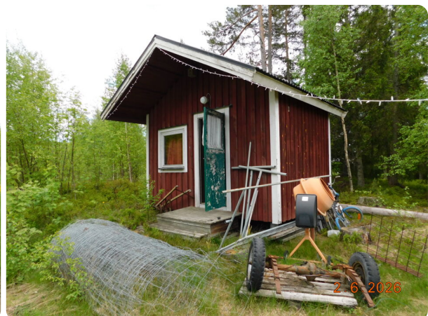
Foto övrig byggnad, friggebod, rödmålad träfasad med vita detaljer.
