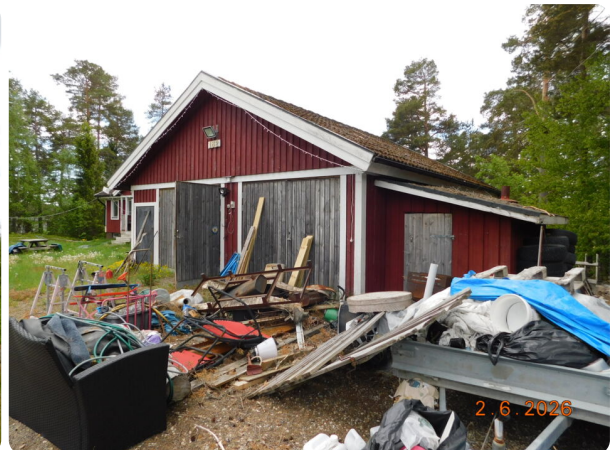
Foto övrig byggnad, garage, rödmålad träfasad med vita detaljer, slagportar.
