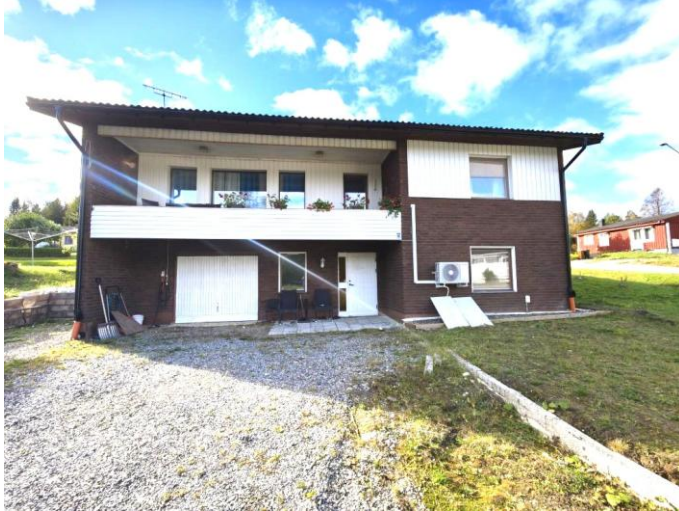
Foto, huvudbyggnad, fasad i brunt tegel med vita detaljer.
