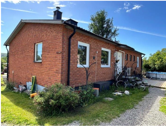
Foto, bostadshus. Entréfasad mot gården. Byggnad med tegel- och träfasad
