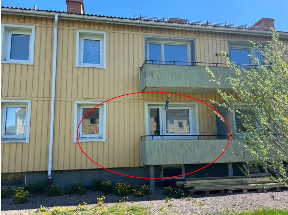
Foto taget utvändigt på värderingsobjektet. Flerbostadshus i två våningar, med gul fasad och vita trädetaljer.
