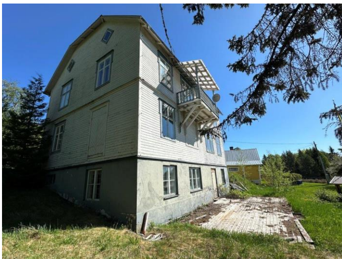
Foto, fasad mot baksidan med ljus träpanel samt vita och gråa detaljer. Trädgård med äldre trädäck.
