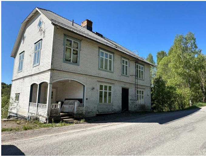
Foto, entréfasad med ljus träpanel samt vita och gråa detaljer.
