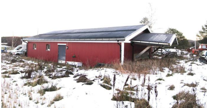
Foto stall med röd plåtpanel och vita detaljer, svart plåttak.
