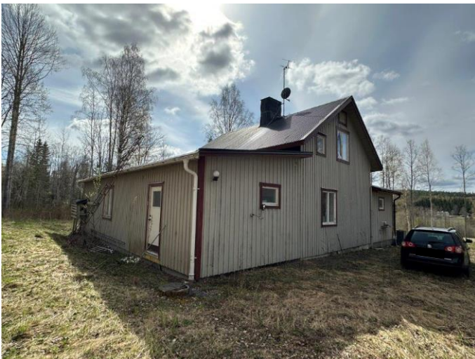
Foto fasad mot baksidan av bostadshus med gråmålad träpanel med vita och röda detaljer. Tomt med gräsmatta, buskar och träd.
