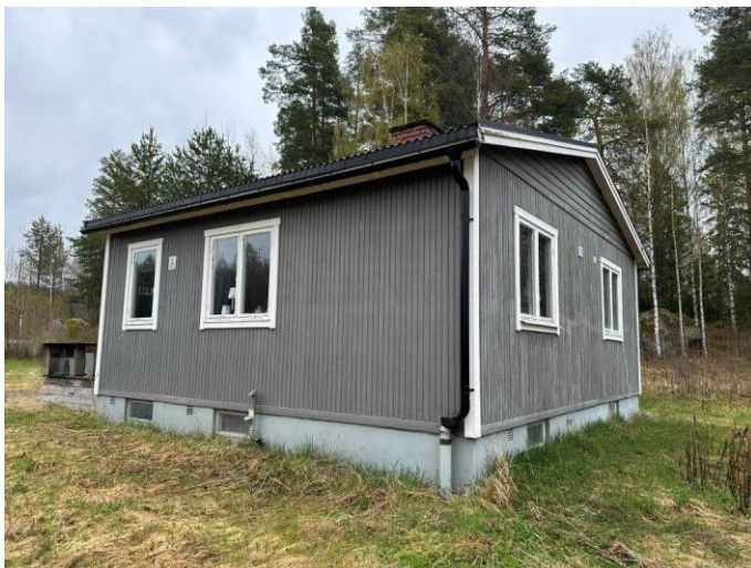
Foto, bostadshus. Fasad med gråmålad träpanel och vita samt detaljer. Tomt med gräsmatta.
