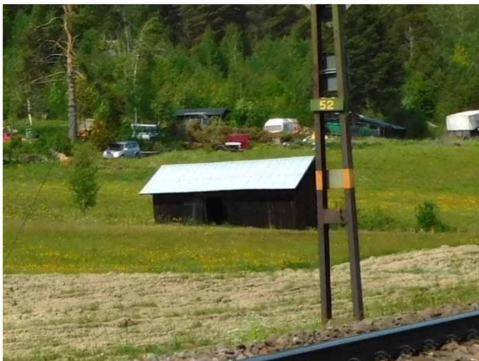
Foto, övrig byggnad 3, äldre hölada.
