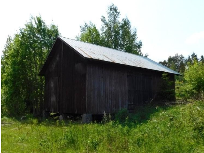
Foto, övrig byggnad 4, äldre hölada.
