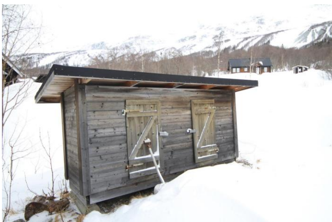
Foto, förråd med träpanel och plåttak.
