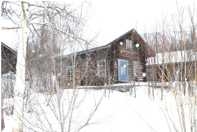
Foto, huvudbyggnad, timrat Attefallshus, med uteplats.
