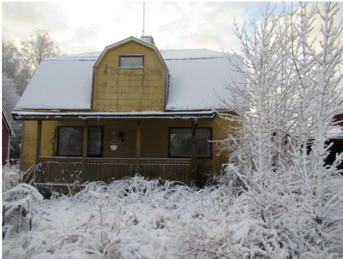
Foto, huvudbyggnad. Gulfärgade eternitplattor med bruna detaljer samt högbevuxen trädgård
