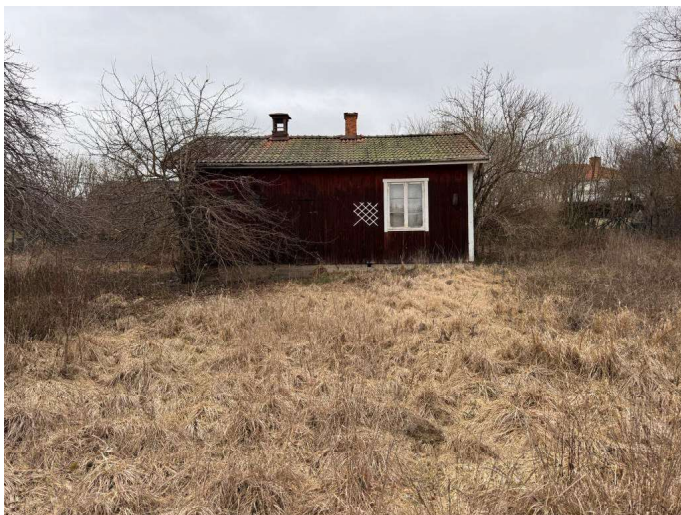
Foto, Förrådsbyggnad på tomten, röd träpanel med vita detaljer.
