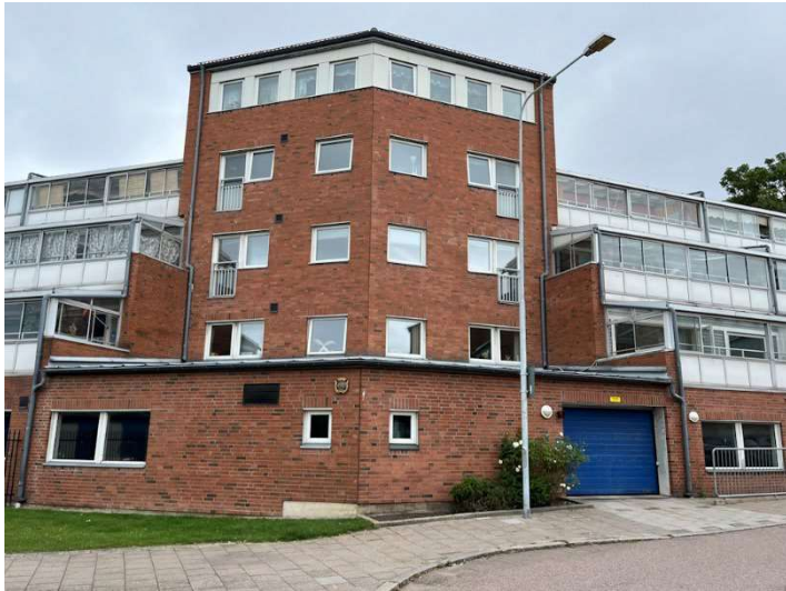
Foto, fasad (ut mot Gustav Adolfs gata)
