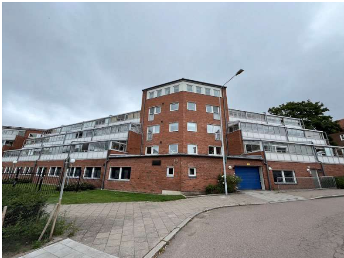
Foto, fasad (ut mot Gustav Adolfs gata)
