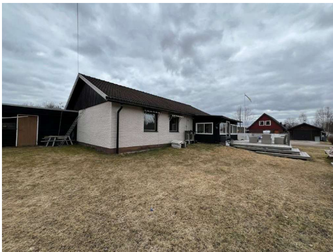
Foto, Huvudbyggnad, vit tegelfasad, inglasad altan med anslutande trädäck.
