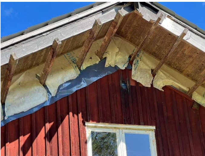
Foto, huvudbyggnad, pågående projekt.
