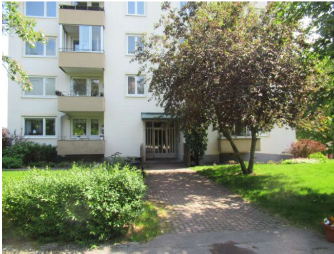
Foto, huvudbyggnad från entré.
