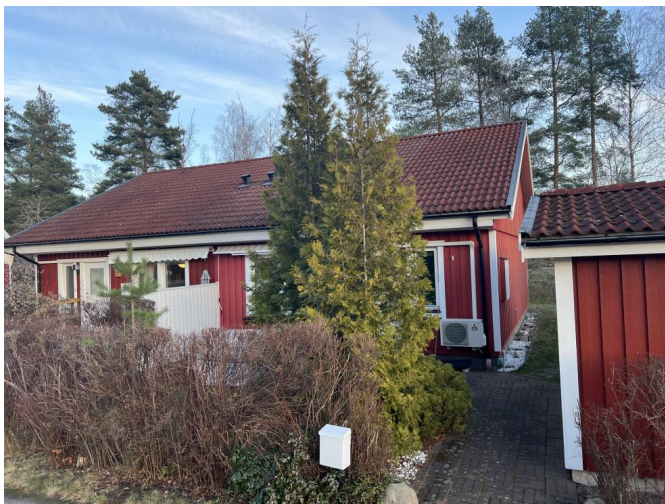
Foto, byggnad. Parhus med röd träpanel med vita detaljer samt trädgård med häck )
