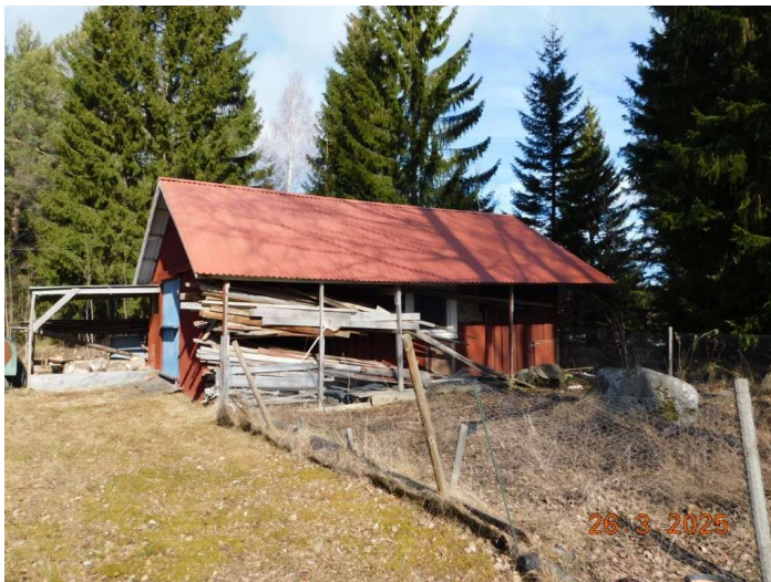
Foto, byggnad 3, hönsbushus, rödmålad träfasad.
