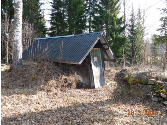
Foto, byggnad 5, jordkällare, plåttak.
