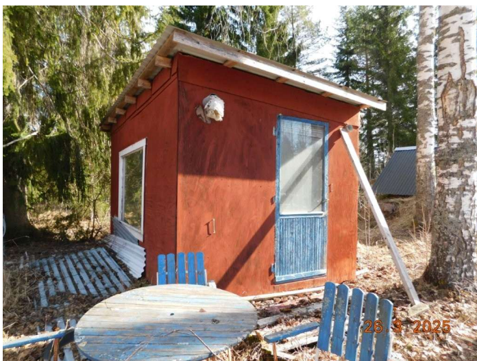
Foto, byggnad 4, stuga, rödmålad fasad.
