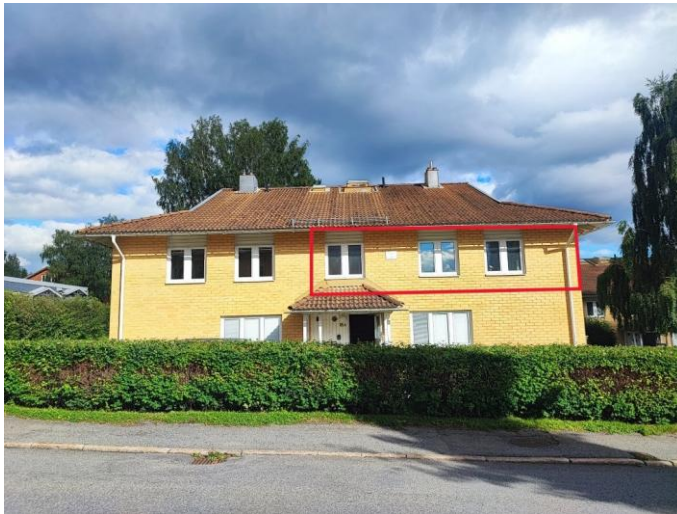
Foto, entréfasad, markeringen visar läget för lägenheten.
