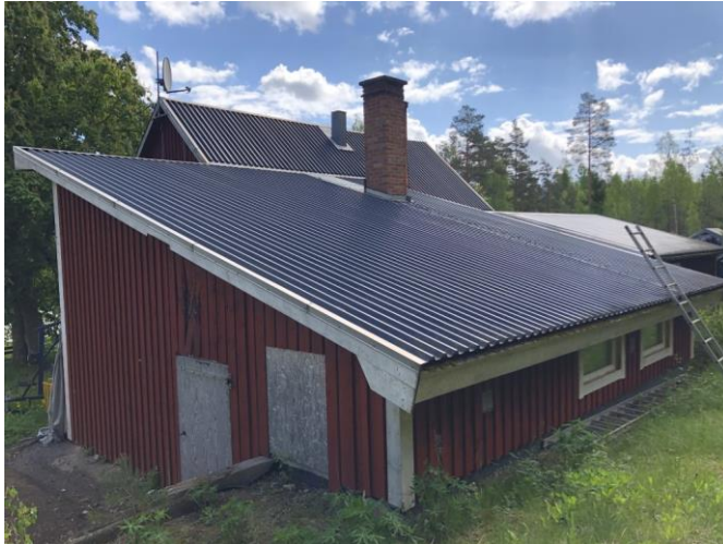
Foto, huvudbyggnad. Tillbyggnad på bostadshuset med röd fasad och vita detaljer, vy från baksidan.
