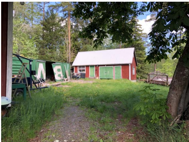
Foto, byggnad. Uthus med röd fasad med vita och gröna detaljer.
