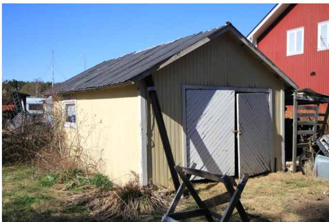
Foto, äldre garage, gulmålad träpanel, gråa portar.
