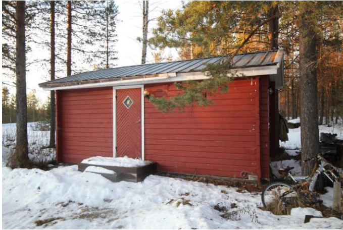
Foto, förråd med rödmålad träpanel och svart plåttak.
