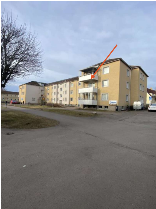
Foto, huvudbyggnad. Pilen visar läget i byggnaden.
