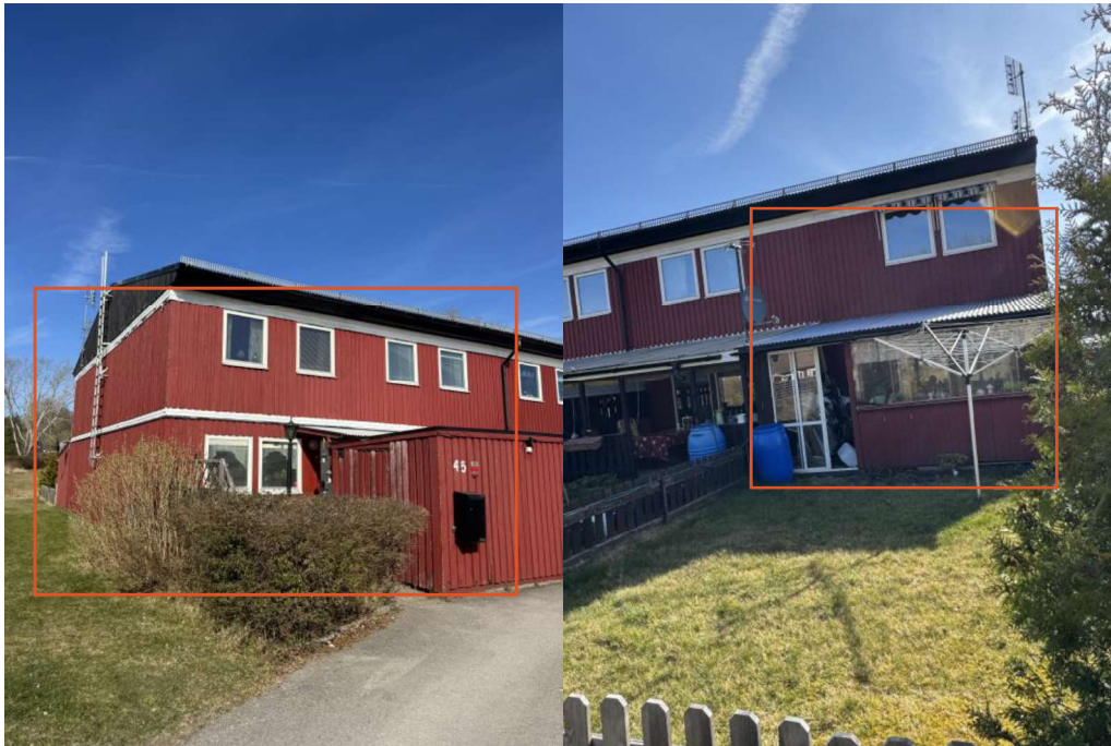
Foto, huvudbyggnad, samt förrådsbyggnad
