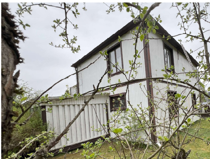
Foto, huvudbyggnad, fasadhörn mot sydöst, altan
