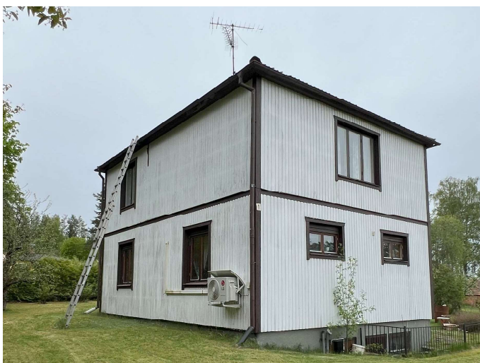
Foto, huvudbyggnad, fasadhörn mot nordöst
