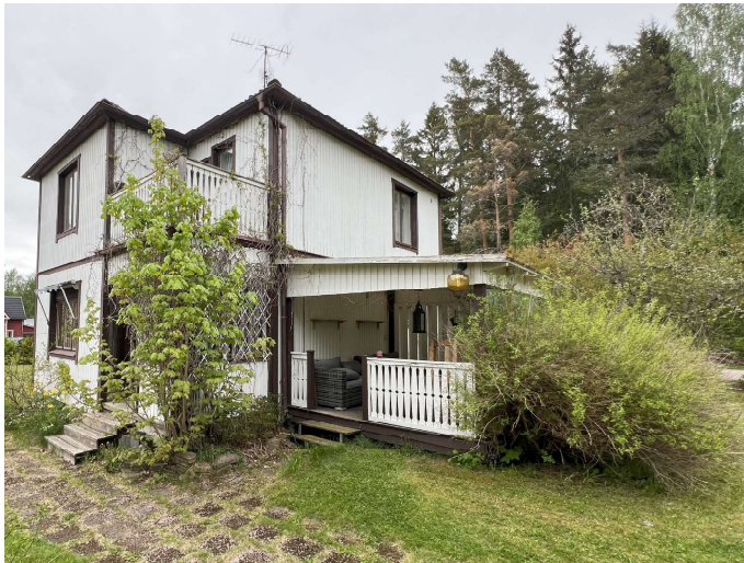
Foto, huvudbyggnad, fasadhörn mot sydväst, altan.
