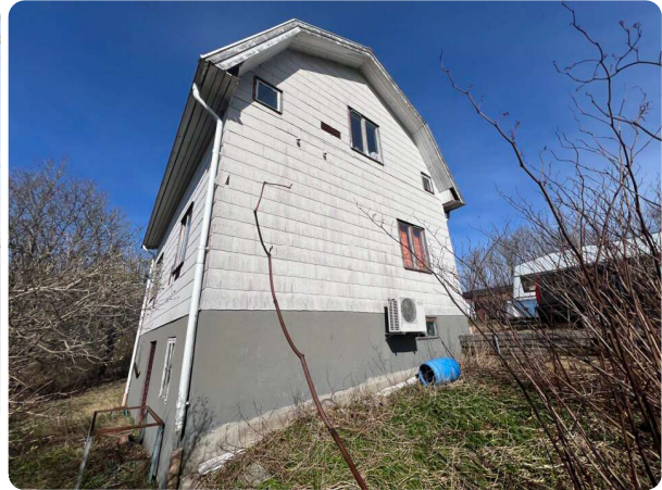
Bostadshus med eternitfasad samt mark med gräs och buskar.
