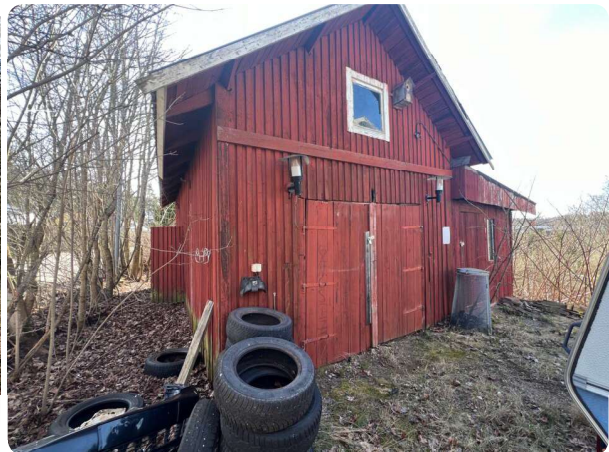
Äldre uthus med röd fasad
