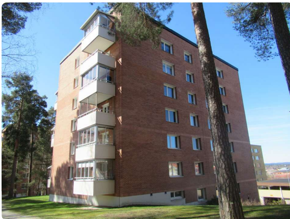
Byggnad med tegelfasad
