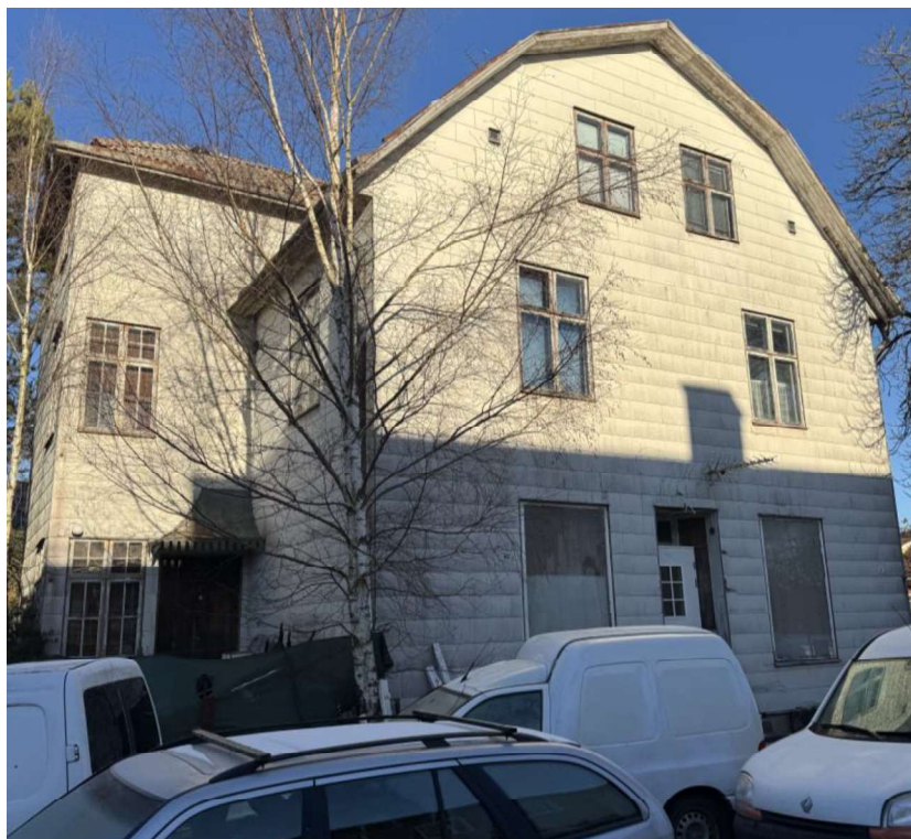
Foto taget utvändigt på värderingsobjektets huvudbyggnad. Vit eternitfasad med vita detaljer och tegeltak.
