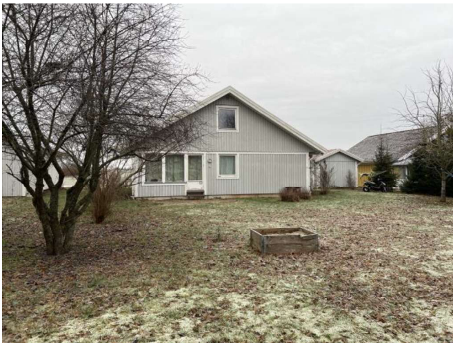
Foto, byggnad. Bostadshus med grå fasad och vita detaljer samt carport och trädgård med gräsmatta och träd.
