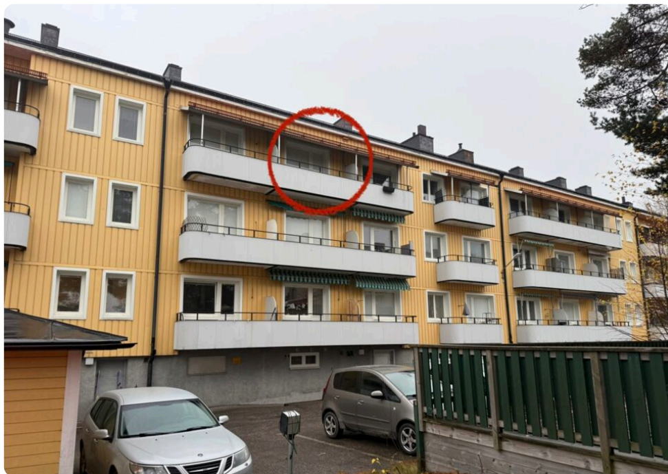
Värderingsobjektets huvudbyggnad. Gul fasad med vita detaljer. Balkong högst upp i byggnaden.
