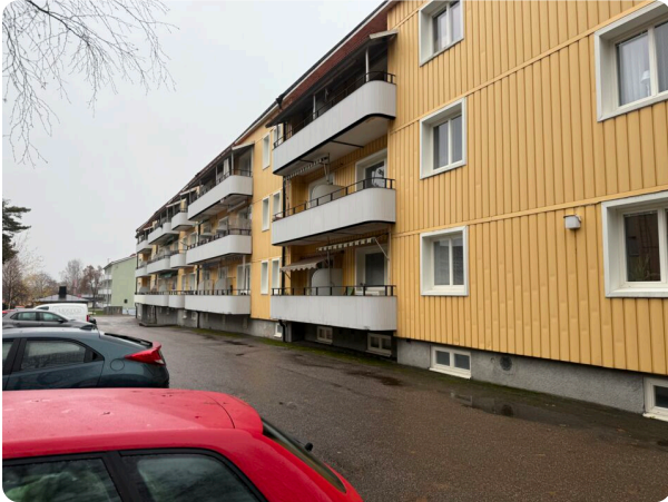
Värderingsobjektets framsida. Gul fasad med vita detaljer. Parkeringsplatser ses i bild.
