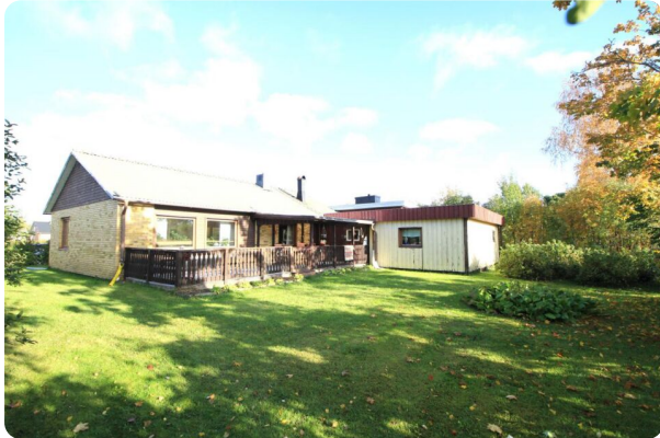
Foto huvudbyggnad, gul tegelfasad, bruna detaljer.
