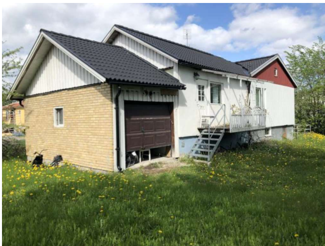
Foto, huvudbyggnad. Bostadshus med fasader av plåt, puts, trä och tegel samt trädgård med gräsmatta, vy från baksidan.
