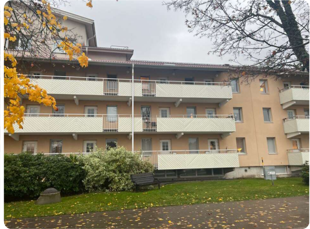
Flerbostadshus med beige fasad och loftgångar
