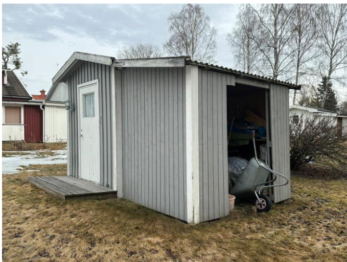
Foto, förråd med vidbyggd öppen del. Grå träpanel samt vita detaljer.
