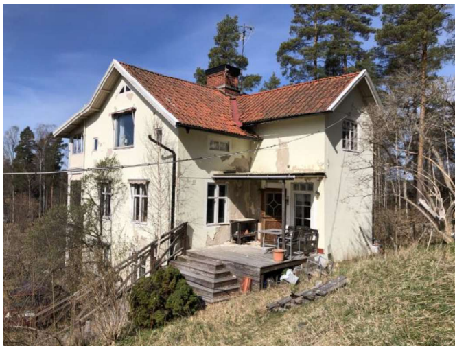
Foto, huvudbyggnad. Bostadshus med ljus, putsad fasad samt infart och sluttande trädgård
